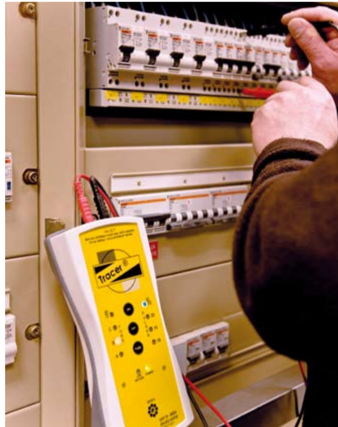
Figuur 3. De tracer heeft pulser 22 gevonden, hetgeen te zien is aan het blauwe lichtsignaal.
